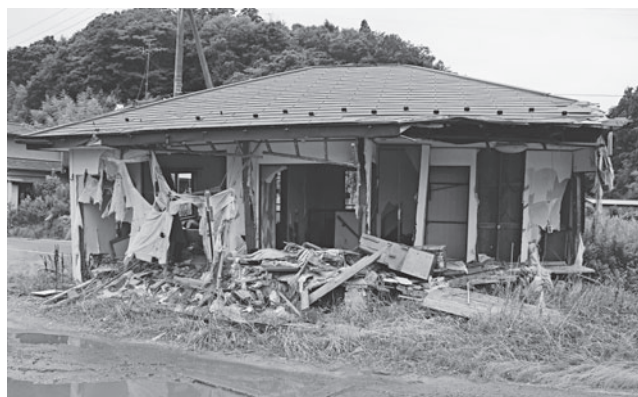
津波により流された家屋
