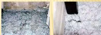
鉄道の振動により、昭和62～63年以降は、アスベスト繊維が粉じんとなって飛散し、倉庫内の商品棚・商品・床面等に降り積もっていた。
