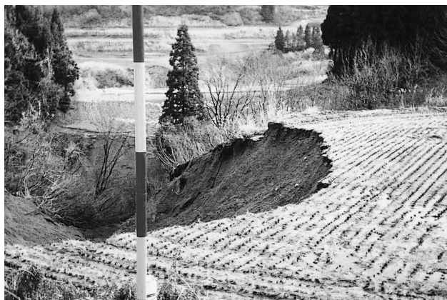
国道352号脇の棚田崩壊
