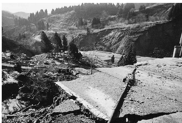
寺野地区 道路崩壊
